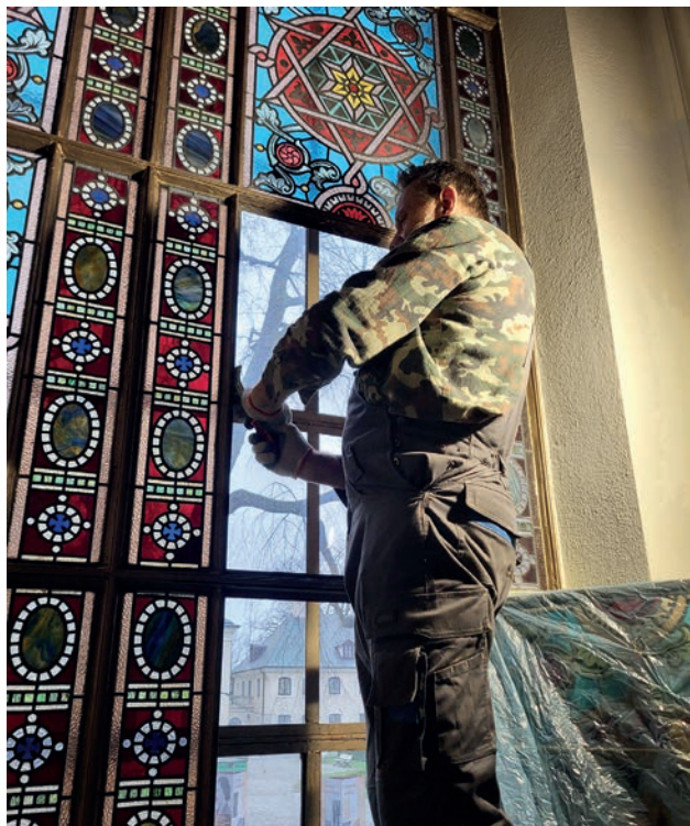
Montaż kwatery witrażowej
