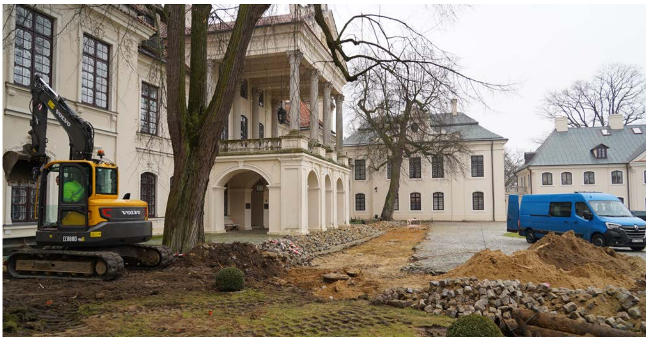
Prace wodno-kanalizacyjne na dziedzińcu
