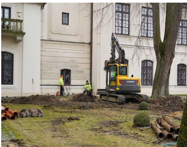
Prace wodno-kanalizacyjne na dziedzińcu
