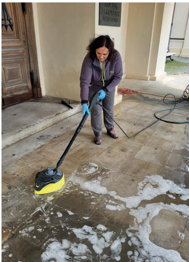
Czyszczenie posadzki piaskowcowej
