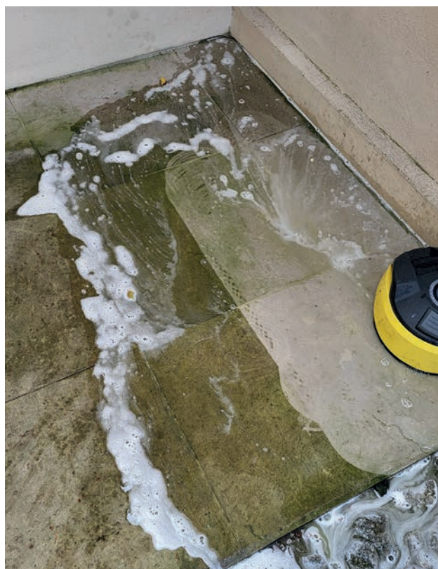
Oczyszczanie podjazdów piaskowcowych metodą hydrodynamiczną
