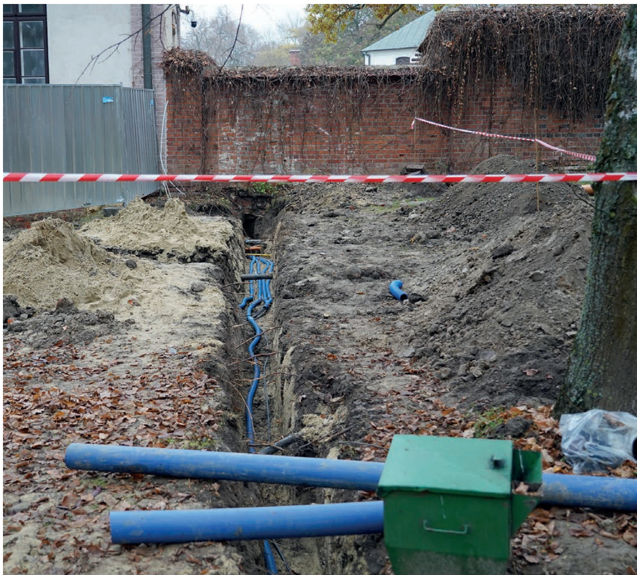
Prace przy przebudowie sieci wodno-kanalizacyjnej
