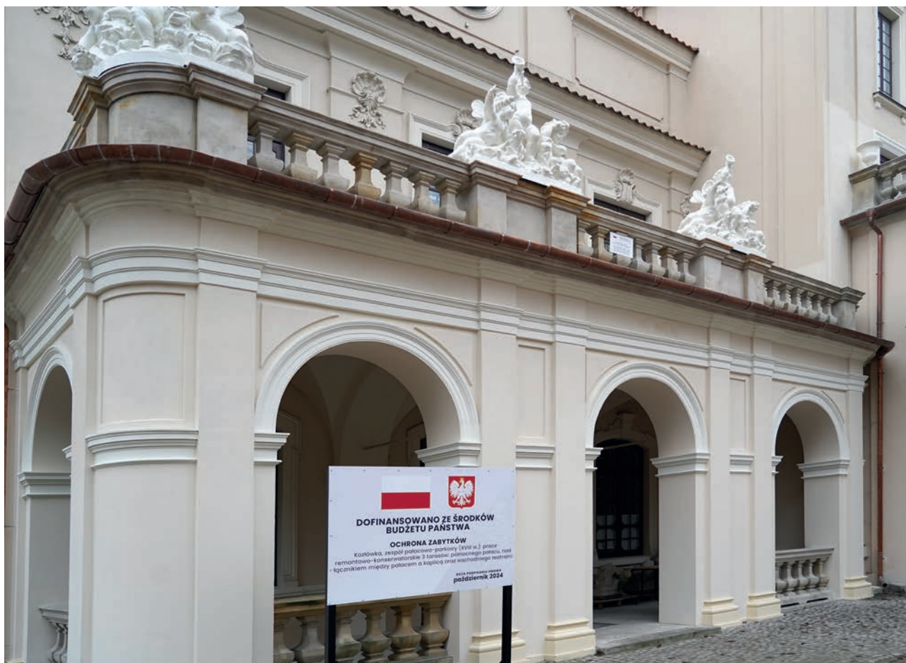
Taras północny w pałacu po remoncie
