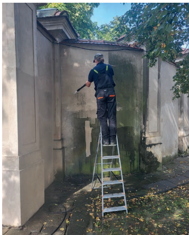
Oczyszczanie murów kurtynowych
