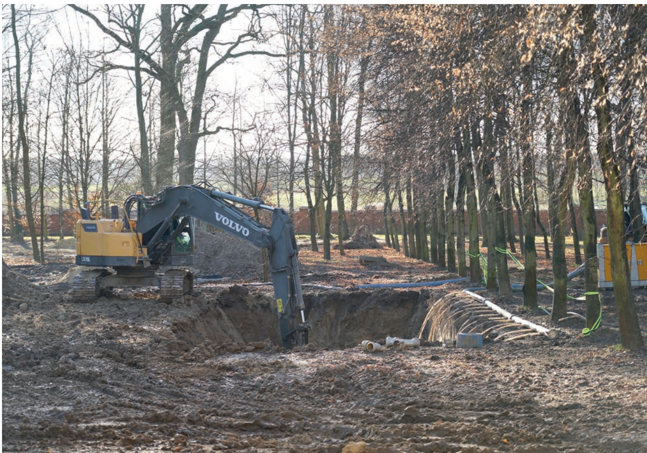
Prace przy przebudowie sieci wodno-kanalizacyjnej
