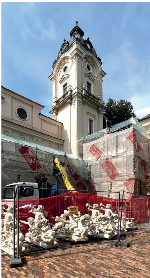
Taras północny w pałacu w trakcie remontu
