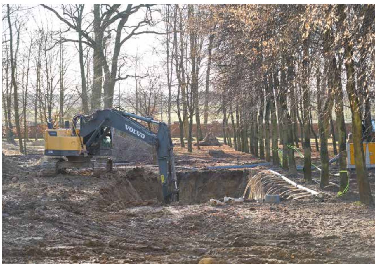
Prace przy przebudowie sieci wodno-kanalizacyjnej
