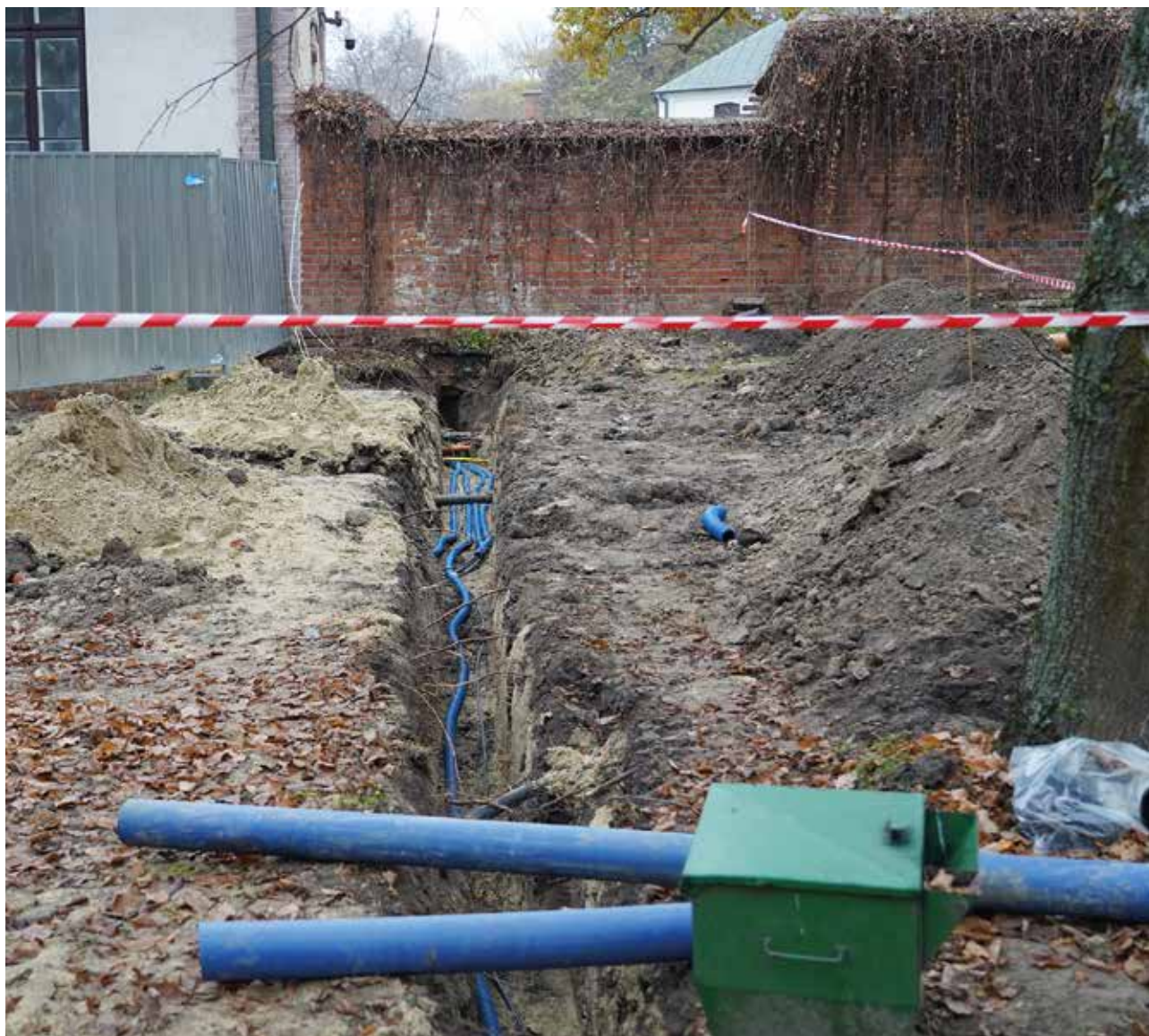
Prace przy przebudowie sieci wodno-kanalizacyjnej
