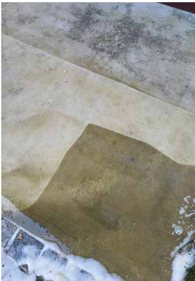
Oczyszczanie podjazdów piaskowcowych metodą hydrodynamiczną
