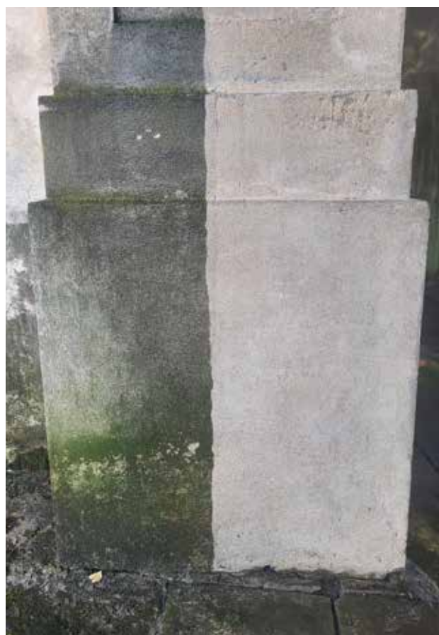
Oczyszczanie murów kurtynowych
