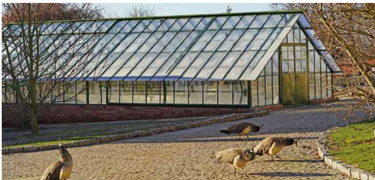
Szklarnia w trakcie i po remocencie
