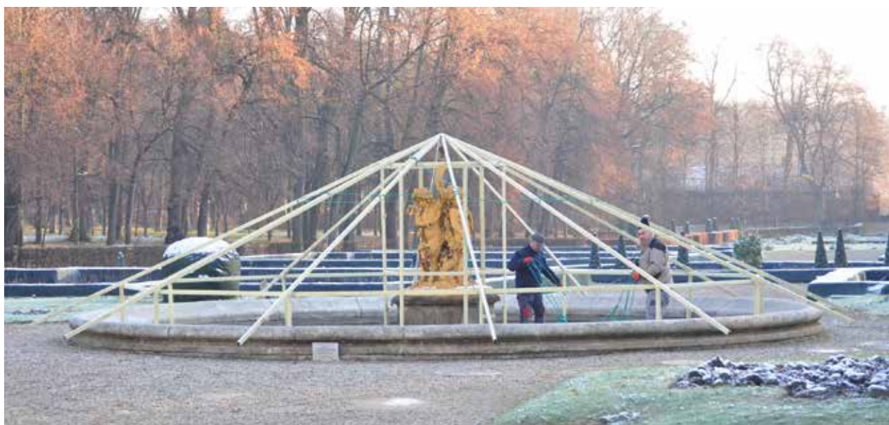
Zakładanie zimowej osłony fontanny
