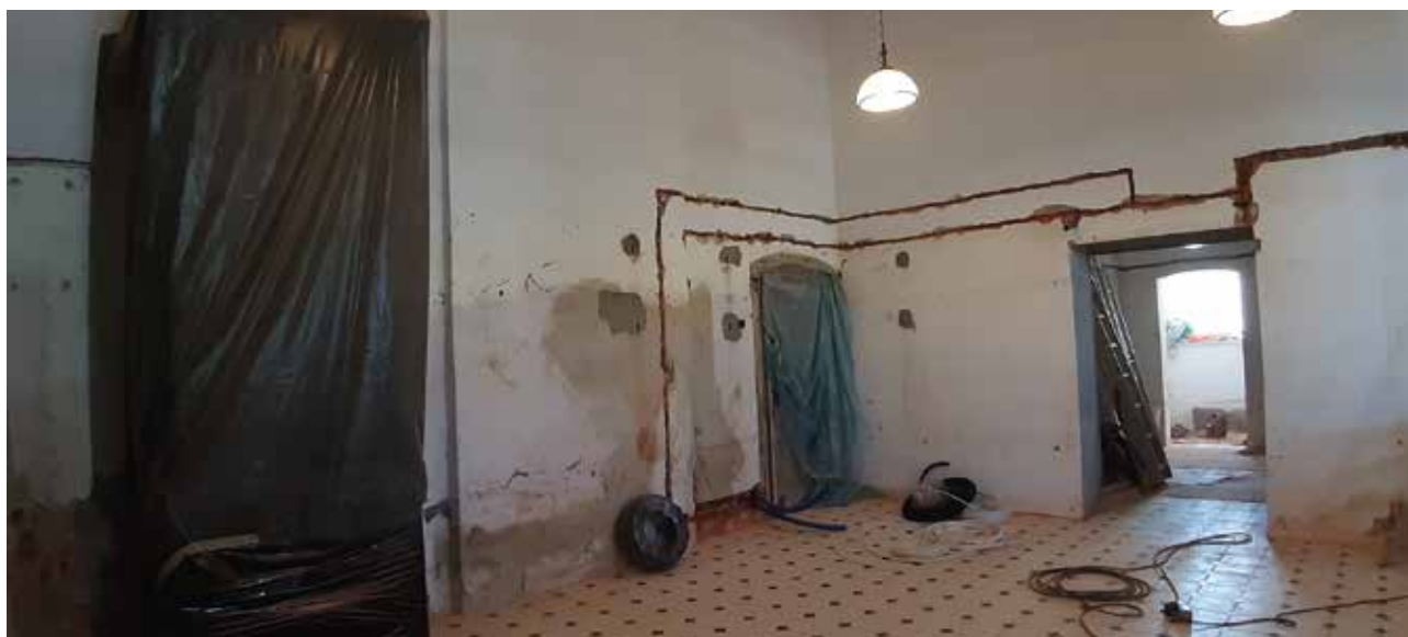
Prace remontowe w nowym pomieszczeniu wartowni
