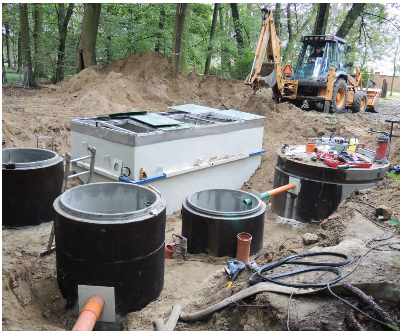
Instalacja nowej oczyszczalni ścieków
