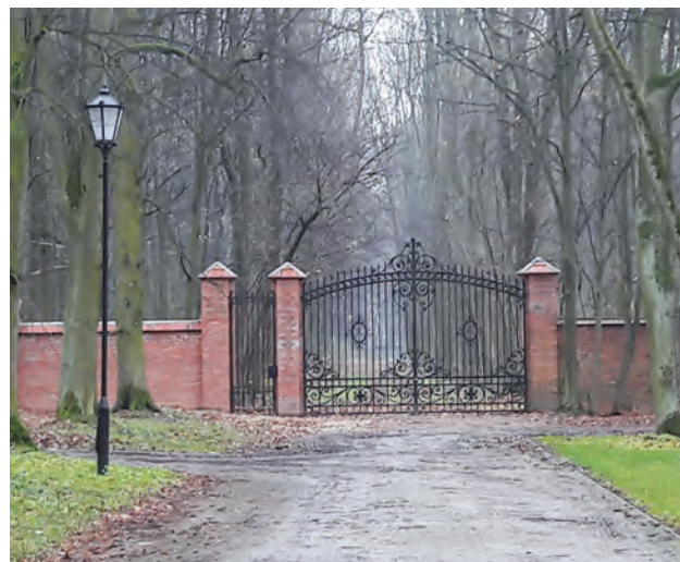
Fragment ogrodzenia z bramą po remoncie
