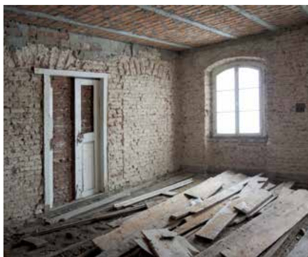
Wnętrze oficyny południowej przeznaczonej do remontu
