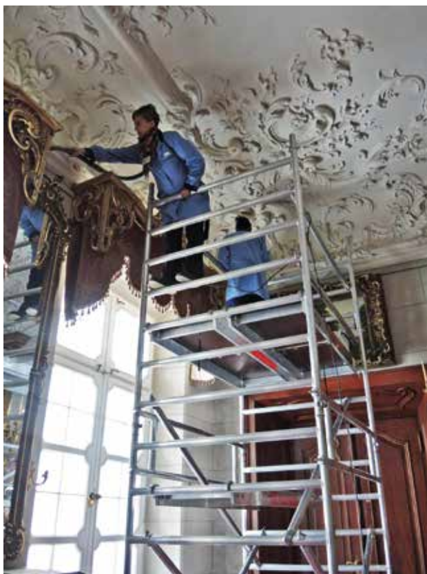
Odkurzanie sztukaterii sufitowych
