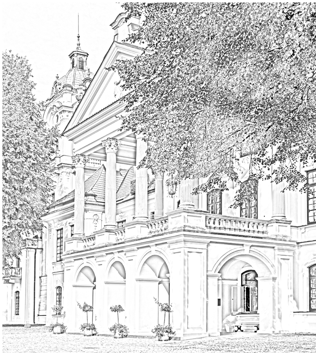
Pałac Zamoyskich w Kozłówce, elewacja frontowa
